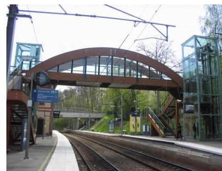
Figure 316 : Passage supérieur et ascenseurs à Saint-Nom-la-Bretèche
