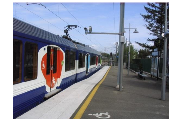
Figure 312 : Matérialisation accès PMR depuis le quai. Berlingot orange sur porte et surélévation / signalisation de quai / bande podotactile
