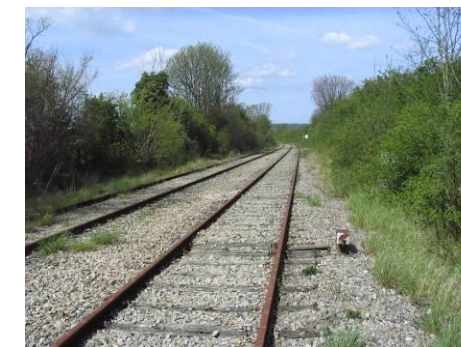
Figure 348 : Section à traverses bois à hauteur de Bailly
