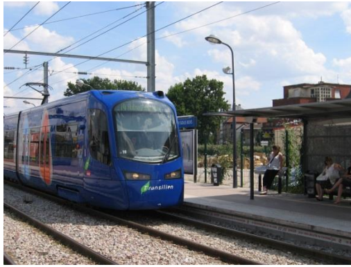
Figure 351 : Tram-Train - ligne T4. Vue du matériel roulant (modèle Avanto de Siemens), du pantographe et de la caténaire
