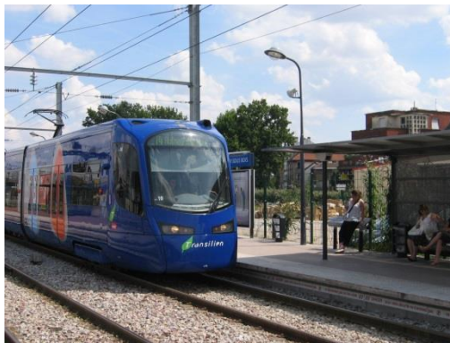
Figure 305 : Tramway T4 à Aulnay-sous-Bois
