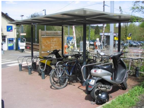
Figure 319 : Parc à vélos à la gare de Saint-Nom-la-Bretèche
